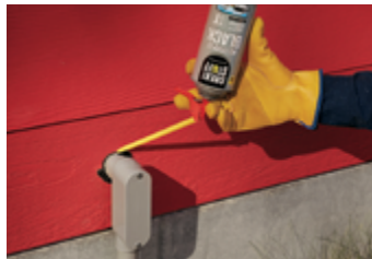
En torno de líneas eléctricas
