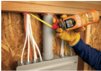
Penetraciones eléctricas
