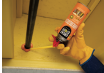
Penetraciones de tuberías
